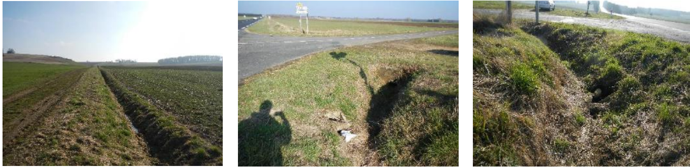
Photo 6 Fossé existant récoltant les eaux du BVN B
